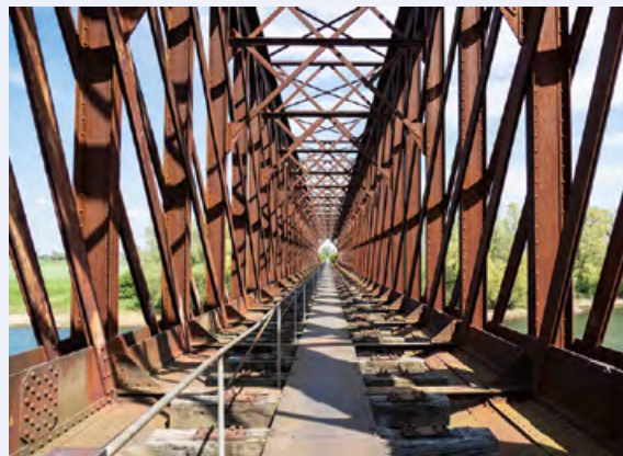
Rens Hubers - Spoorbrug bij Griethausen
